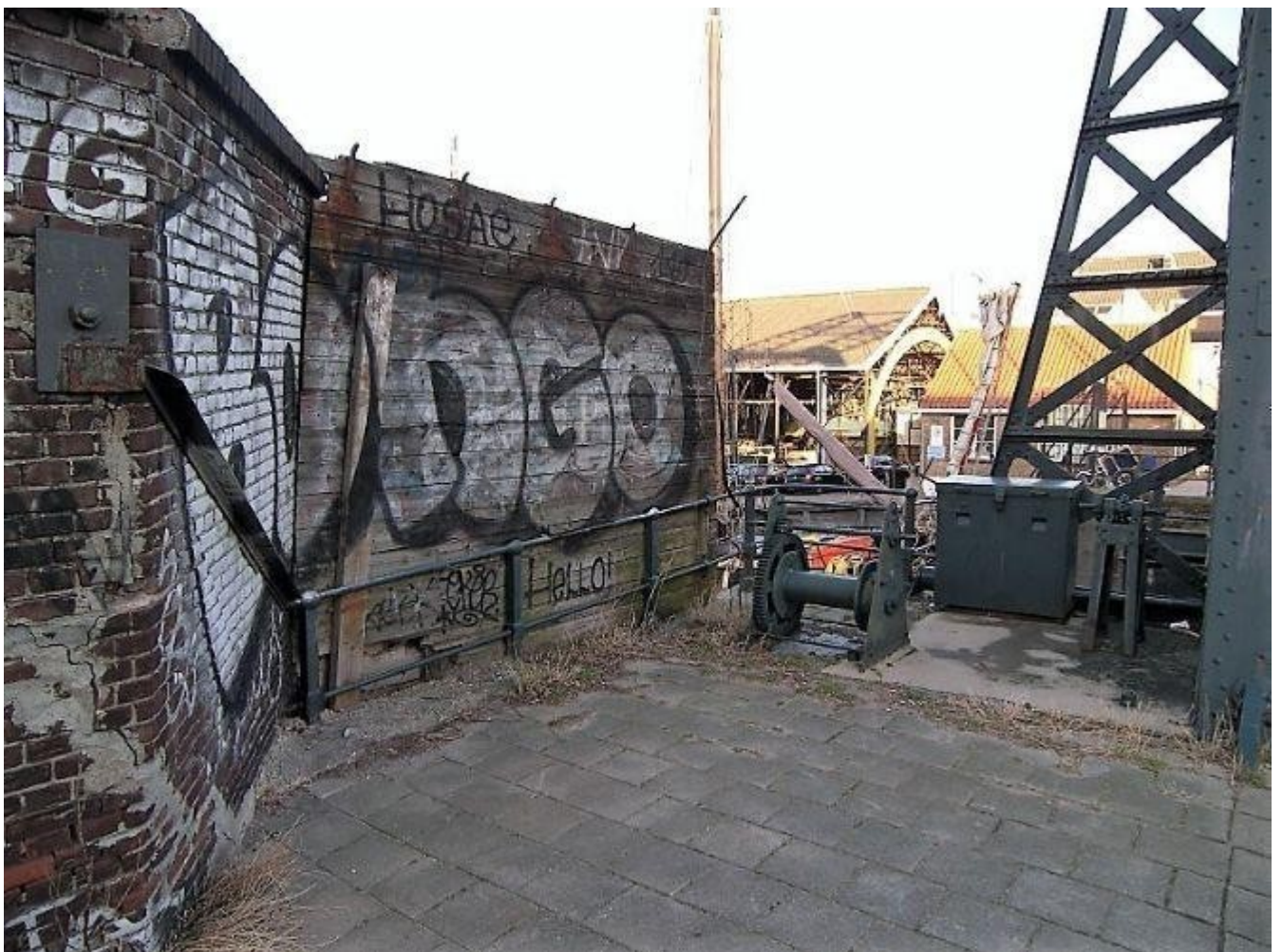
Afbeelding 4 – hekwerk brug nr. 80
