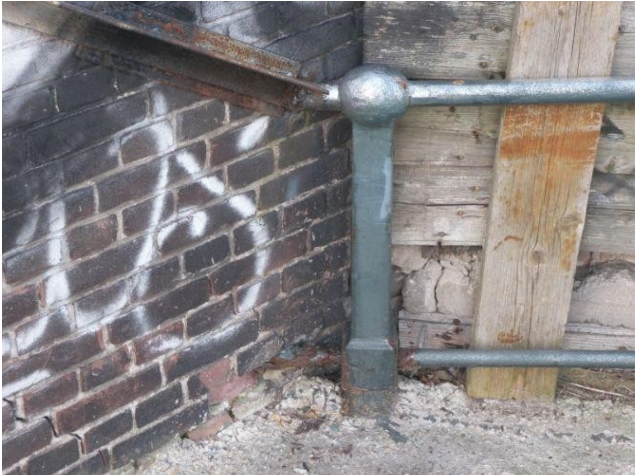
Afbeelding 5 – hekwerk brug nr. 80 verankert aan muur
