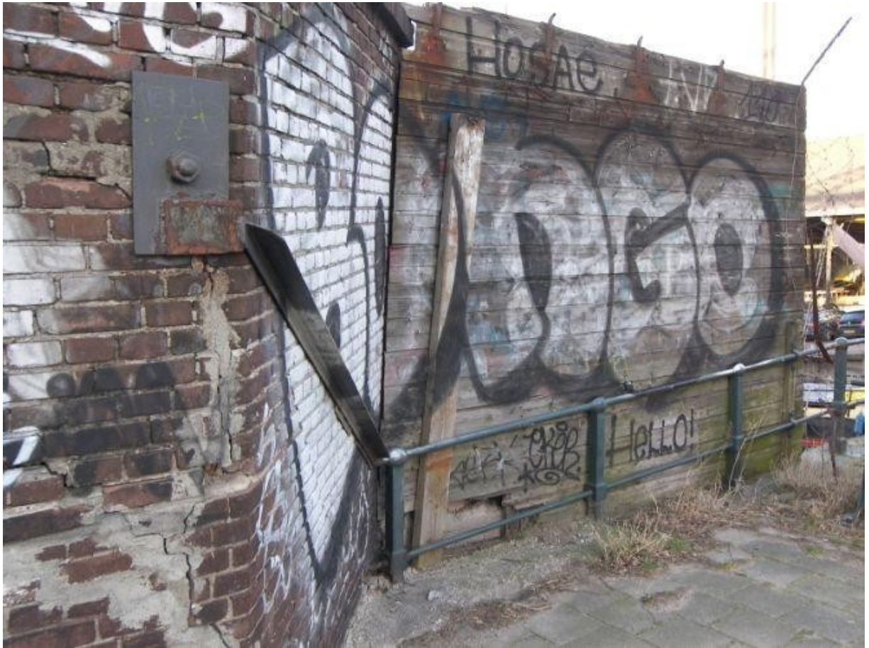
Afbeelding 7 – hekwerk brug nr. 80 d.m.v. smeedwerk verankerd met de stenen muur
