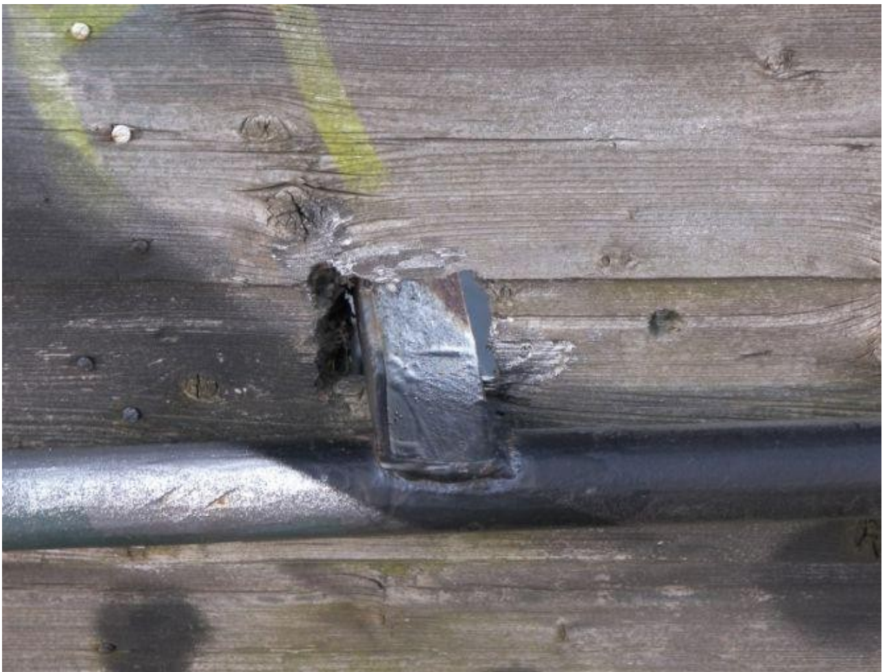
Afbeelding 6 – hekwerk brug nr. 80 d.m.v. smeedwerk verbonden aan achterliggende bebouwing (orde 3)
