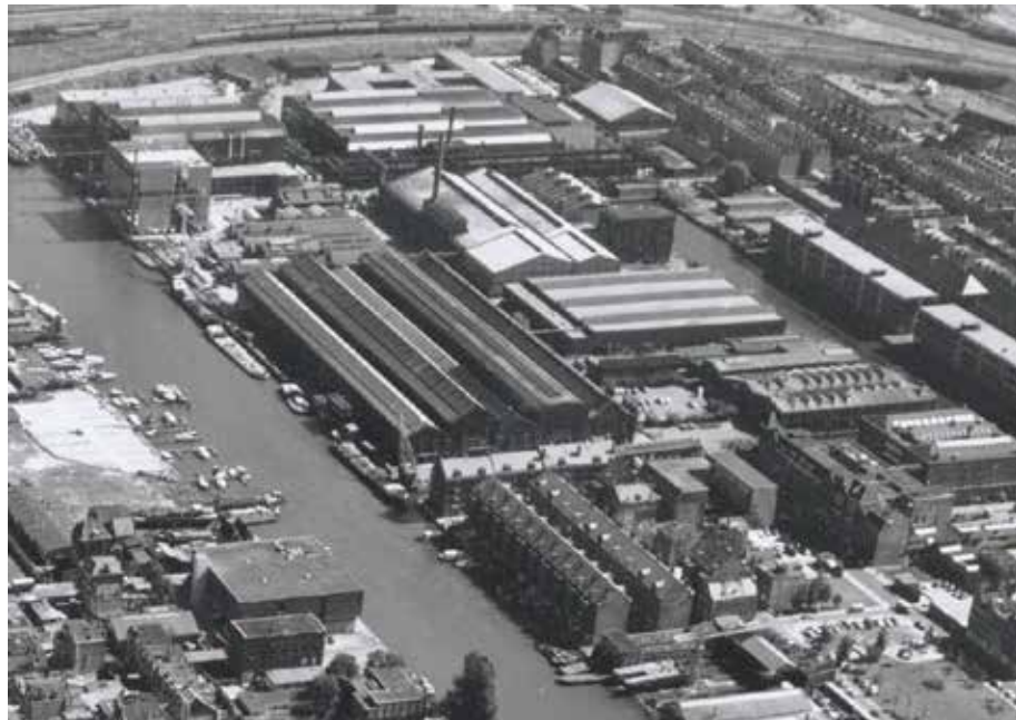
Afb. 15 Het fabrieksterrein van Stork Werkspoor Diesel in 1974.
