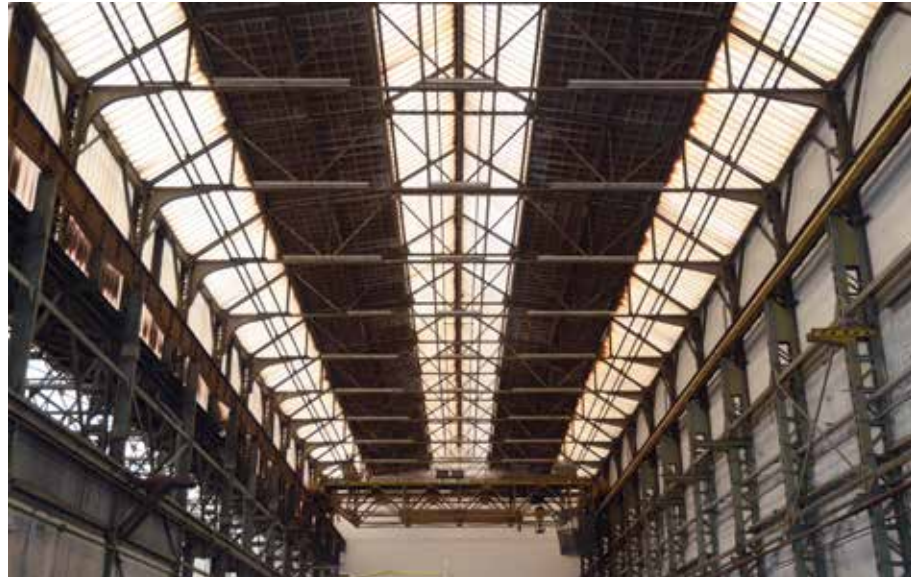
Afb. 21 Noordgevel en draagconstructie van de Van Gendthallen.
