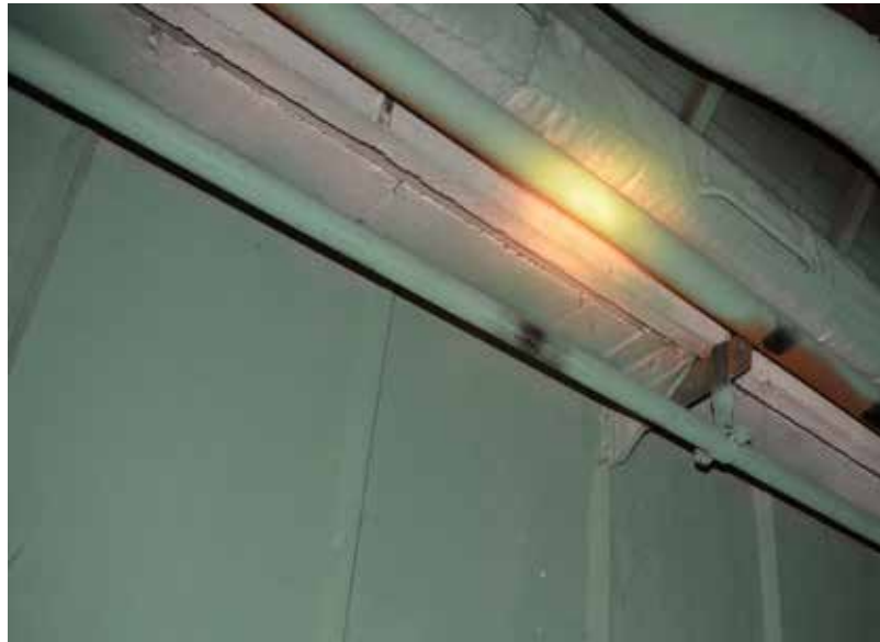
Afb. 17 De dakrand/goot van de koperslagerij, met daaronder de glasstrook, gevat in stalen profielen.
