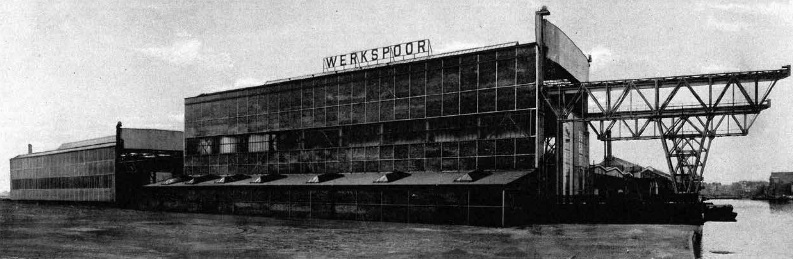
Afb. 27 Stelplaats 3 en Machinale Werkplaats 3 na de voltooiing, 1931.
