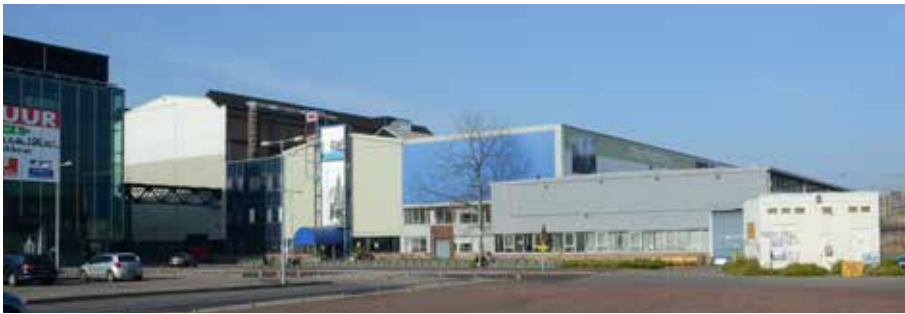
Afb. 1 Zuid- en oostgevel van het cluster gebouwen rond Stelplaats 3.
