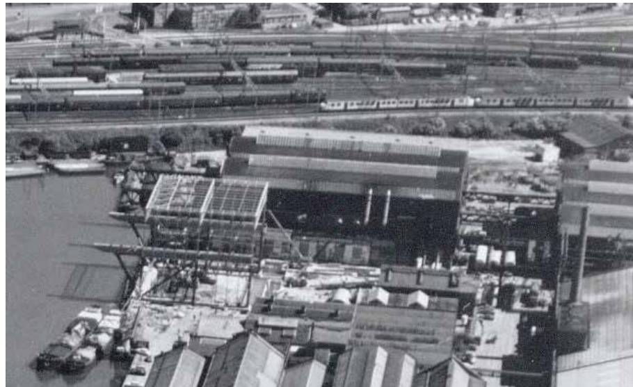
Afb. 40 Montage- en Proefstandgebouw in aanbouw, 1974.
