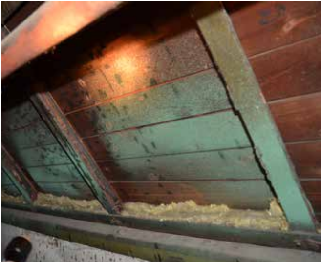
Afb. 18 De schuine glasstrook tussen Stelplaats 3 en de Koperslagerij is dichtgemaakt met houten planken.
