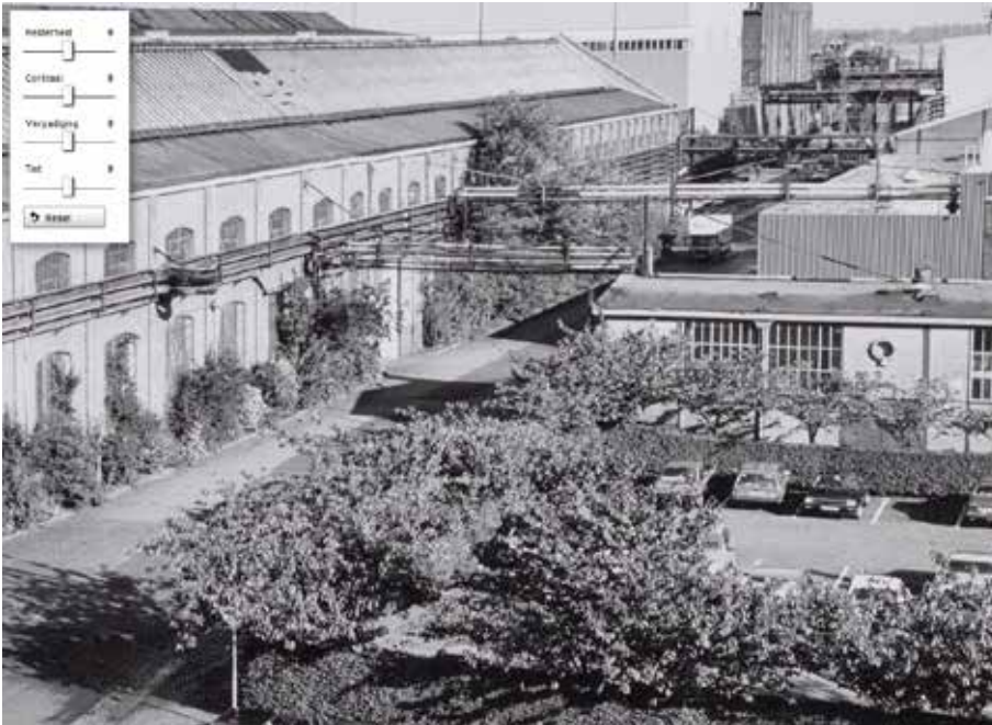
Afb. 32 Bovengrondse leidingen over de Oostenburgermiddenstraat, op de achtergrond de kraanbanen tussen stelplaats en machinale werkplaats, 1985.
