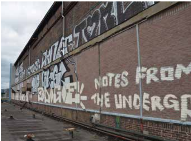
Afb. 20 De oorspronkelijke horizontale glasstrook in de zuidgevel is dichtgezet met halfsteens metselwerk.
