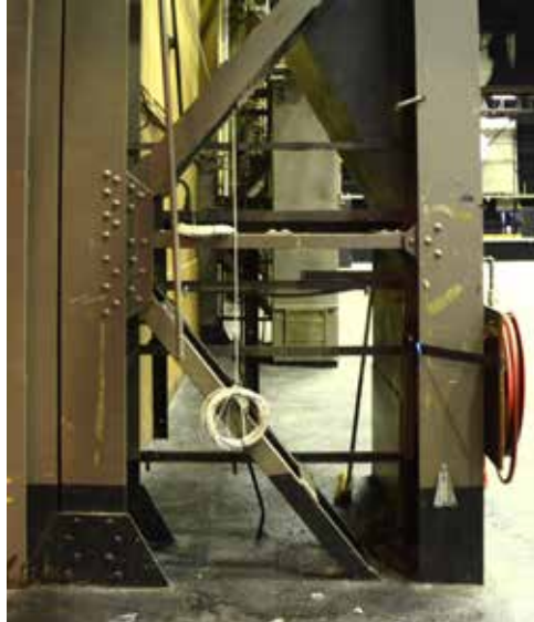
Afb. 10 Samengestelde kolom tussen 1929-hal en 1939-hal.
