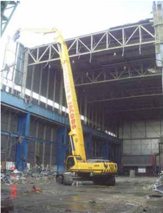
Afb. 45 De zware vollwandprofielen en het lichte dak van het TM620-gebouw, goed zichtbaar tijdens de sloop.
