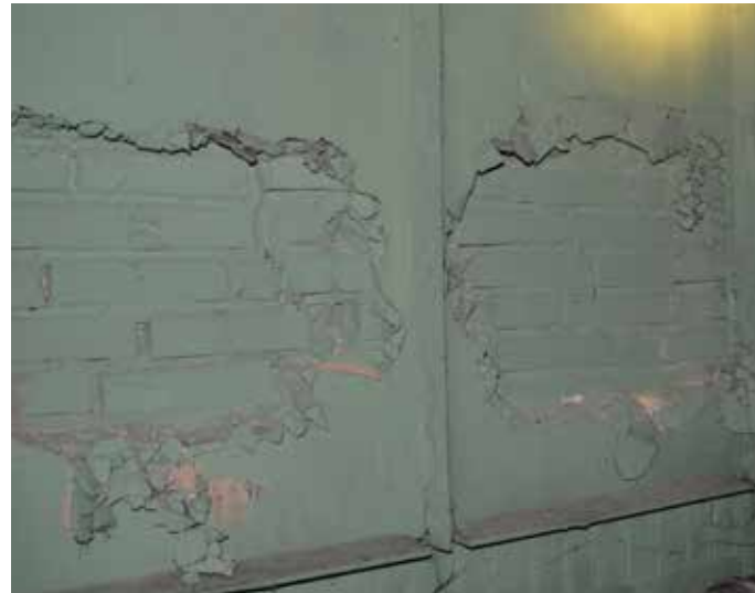
Afb. 19 Aan de buitenkant van Stelplaats 3 is een halfsteensmuur tegen de gevel geplaatst. Diverse draadglazen panelen zijn gebroken. Duidelijk zichtbaar is dat hier wordt aankeken tegen een buitendetailering.
