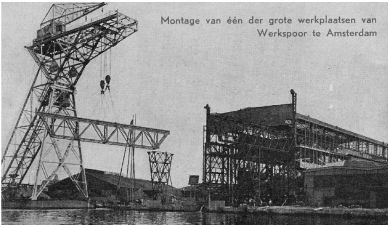
Afb. 26 Stelplaats 3 in aanbouw door de constructieafdeling van Werkspoor.
