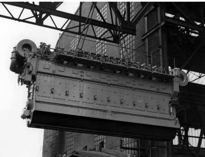
Afb. 17 De dieselmotoren worden uit Stelplaats 3, via de kraanbaan in de machinekamer van een schip geladen.
