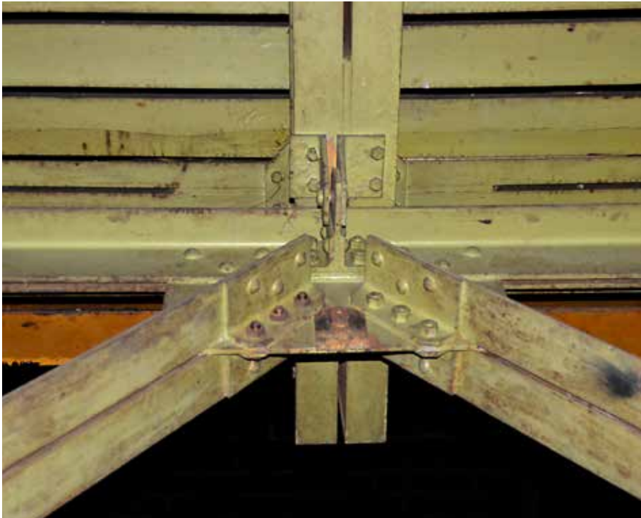
Afb. 8 Geprefabriceerde geklonken constructieonderdelen werden ter plaatse met behulp van boutverbindingen aan elkaar verbonden.
