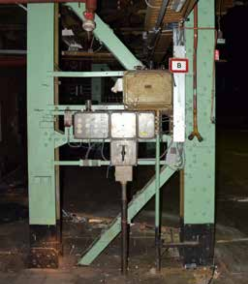
Afb. 9 Samengestelde kolom 1929-hal.
