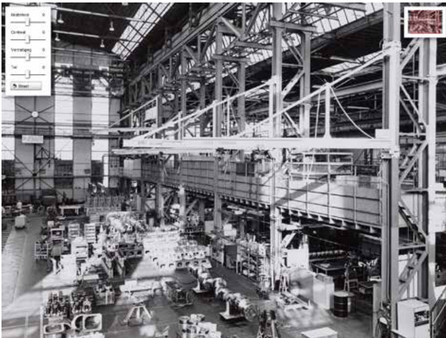
Afb. 24 Zicht op het magazijn tussen Stelplaats 3 en Stelplaats 5.
