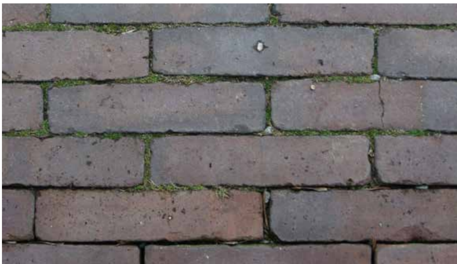
verharding Oostenburgerdwarstraat gebakken klinkers waalformaat (200 x 50 x 85) kleur Bordeaux (HUWA vandersanden)
