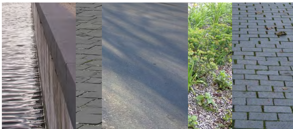
Granieten deksloof, margezone basalt, flaneerzone glad asfalt, plantstrook met puingranulaat en terraszone van natuursteen(graniet)
