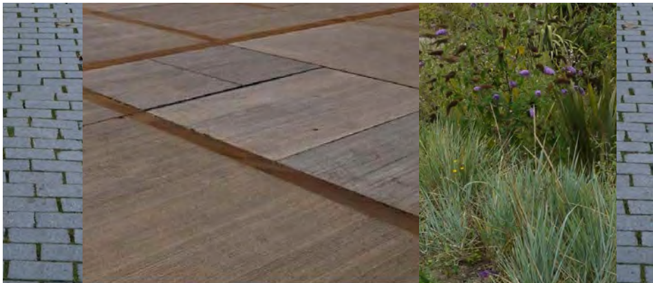
betonplaten met geveegde toplaag en brede staalstrips, pionierbeplanting grassen kruiden en struiken, klinkers in margestrook gevel
