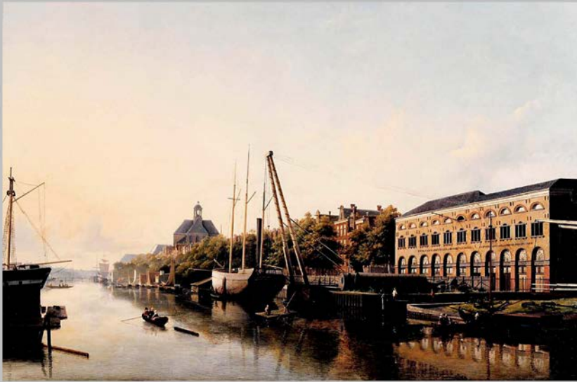
De Nieuwe Vaart 1849. Rechts de Koninklijke Fabriek op de hoek met de Oostenburger Vaart. Aan de kade: de Burg.Huydecoper het eerste stoom-schroefschip dat in Amsterdam werd gebouwd. Op de kade: stoomketels voor de gemalen van de Haarlemmermeer.
