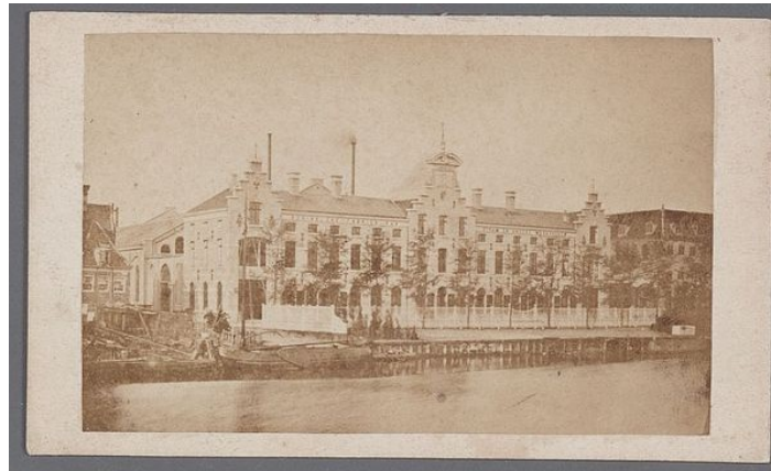
Kantoor- en administratiegebouw van de Koninklijke Fabriek van Stoom- en andere Werktuigen aan de Oostenburgergracht. De geschiedenis van dit gebouw is functioneel, fysiek en typologisch te herleiden tot de periode van de VOC.
