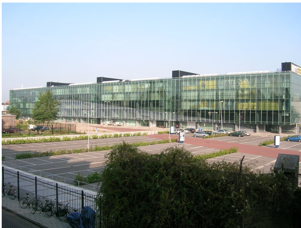
INIT (gezien vanaf de Conradstraat)
