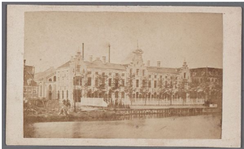
Kantoor- en administratiegebouw van de Koninklijke Fabriek van Stoom- en andere Werktuigen aan de Oostenburgergracht. De geschiedenis van dit gebouw is functioneel, fysiek en typologisch te herleiden tot de periode van de VOC.
