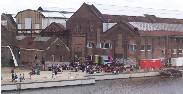
Koudgasgebouw (Roest) en de Van Gendthallen
