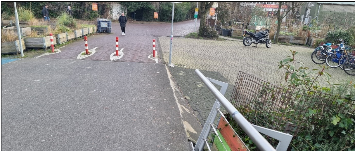
Figuur 4.1: voorbeeld ontbreken valbeveiliging Oosterdoksdraaibrug en paaltjes
